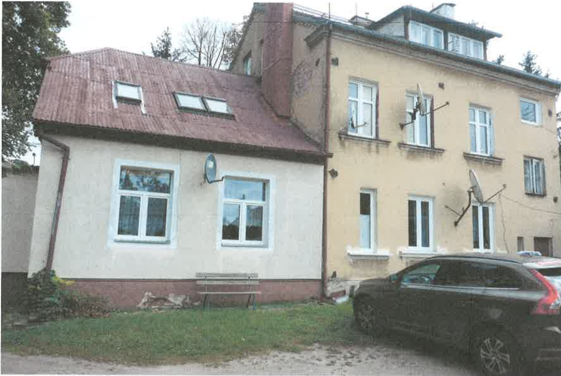
Fotografia nr 1 – widok budynku mieszkalnego w Lidzbarku Warmińskim, ul. Spółdzielców 15
